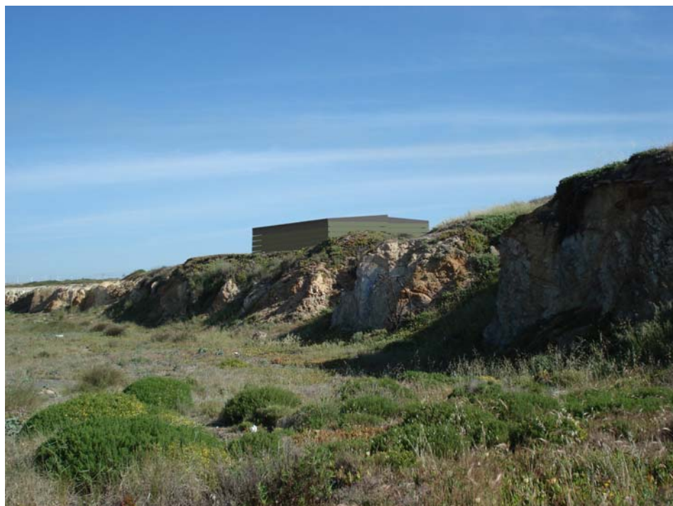
Figura 2 – Fotomontagem da vista SW – SE da Casa das Bombas
